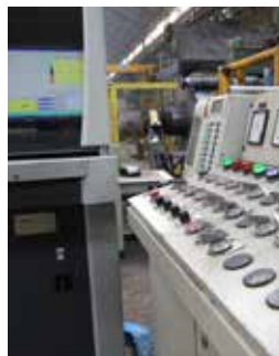
Controllo laser dimensione nastro Sheet size laser test
